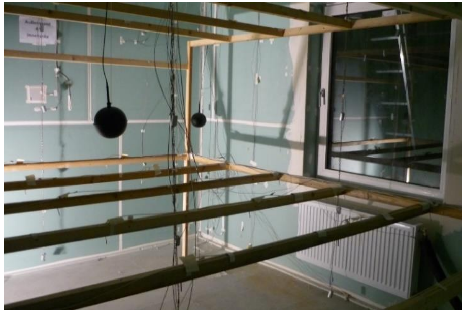
Bild 2: Innenansicht des Messraumes mit Heizkörper unter dem Fenster sowie Lattenkonstruktion zur Positionierung der Sensoren für die Regelung.
